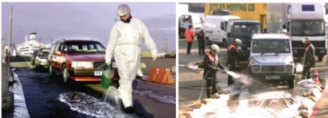
Abb. 5: Teilflächige Fahrzeugdekontamination durch Durchfahren von Desinfektionslösungen in provisorischen Wannen [3], [4]
