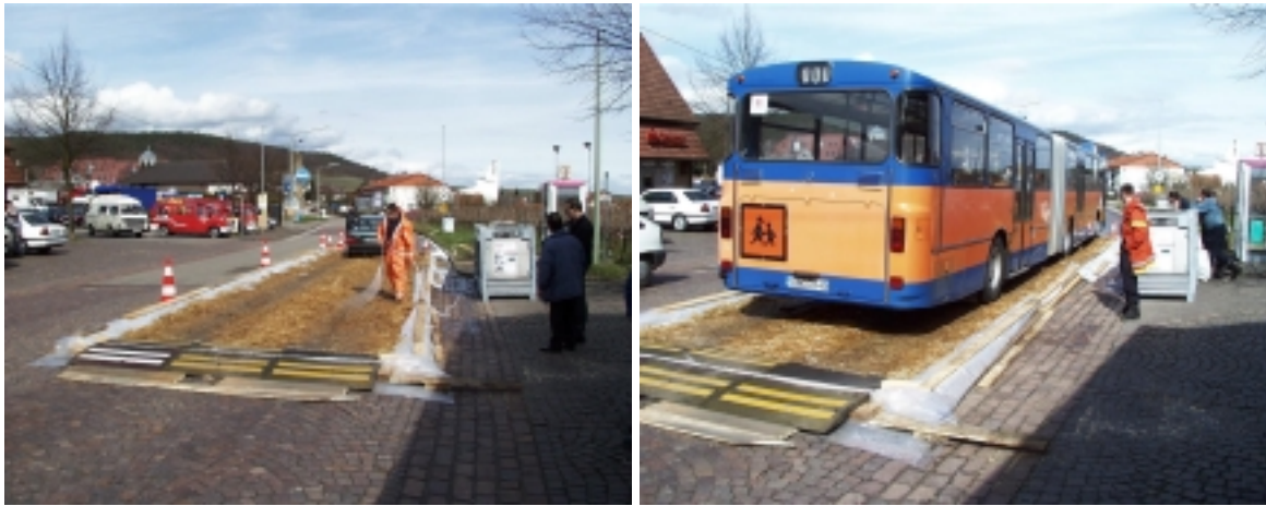
Abb. 6: Teilflächige Fahrzeugdekontamination durch Durchfahren von mit Desinfektionslösungen getränktem Stroh [5]
